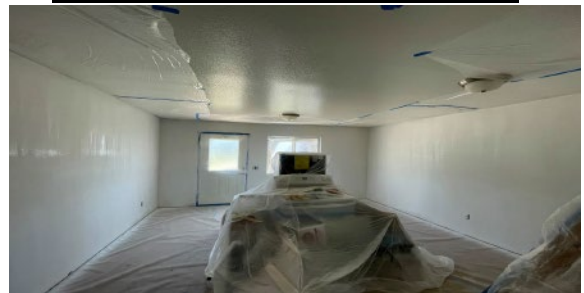
(4) New drywall, texture and primer
