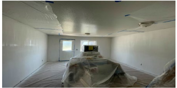
(4) New drywall, texture and primer
